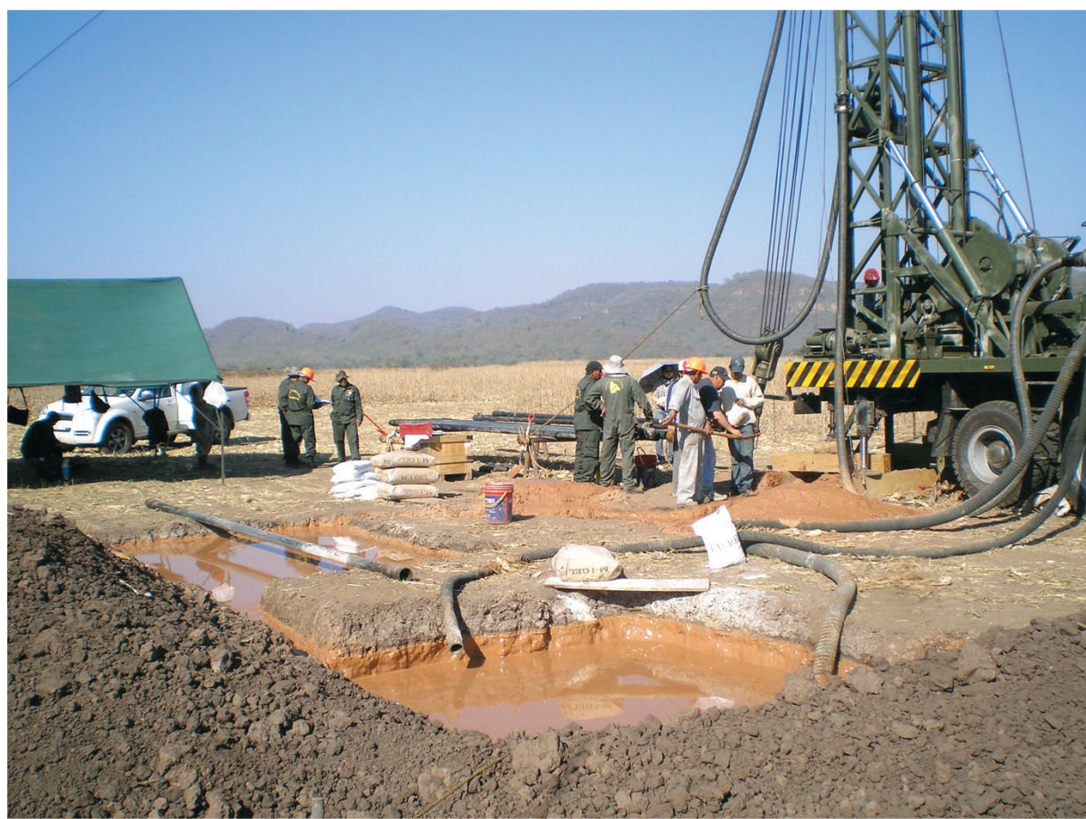
Equipo de perforación y maquinaria de trabajo.
