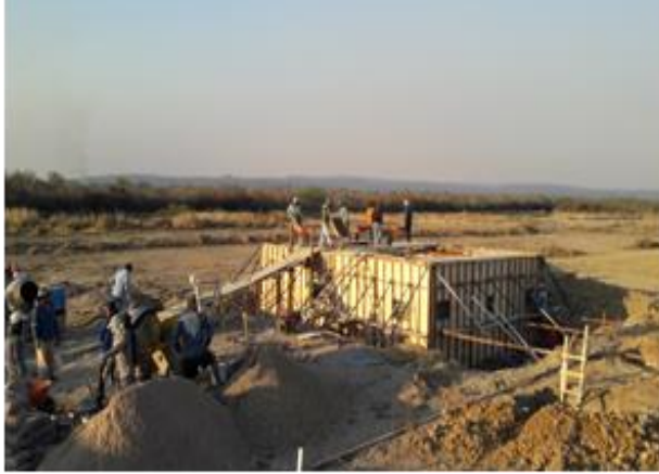
CONSTRUCCION DEL CENTRO DE MEJORAMIENTO GENETICO DE GANADO BOVINO EN EL DPTO DE SANTA CRUZ
