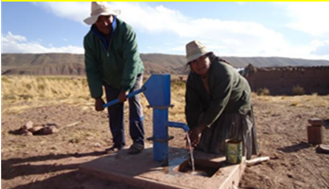
PROYECTO DE AGUA POTABLE PARA CONSUMO HUMANO Y RIEGO EN LA COMUNIDAD DE CARBUYO
