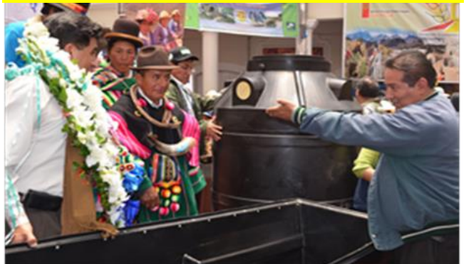
ENTREGA BOMBAS Y DE TANQUES PARA ALMACENAMIENTO DE AGUA COMUNIDAD QASAYA
