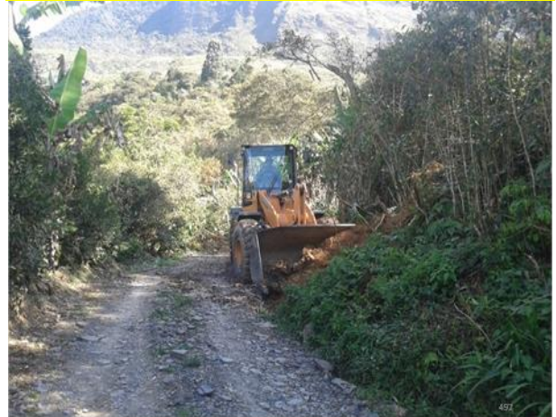
TRABAJOS DE MANTENIMIENTO DE CAMINOS EN LOS YUNGAS DE LA PAZ
