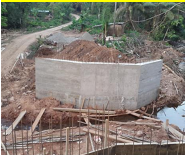
CONSTRUCCION DE PUENTE BOLONIA EN LA COMUNIDAD DEL MISMO NOMBRE
