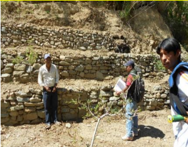
CONSTRUCCION DE TERRAZAS PARA REFORESTACION EN EL MUNICIPIO DE COTAGAITA
