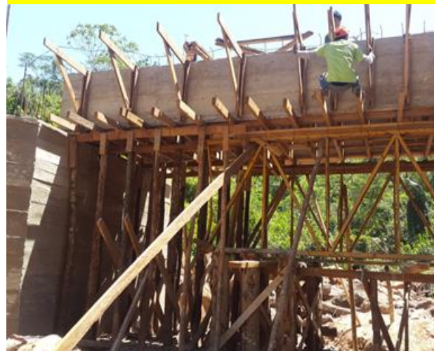
CONSTRUCCION DE PUENTE VECINAL EN LA LOCALIDAD DE TOHOMONOCO
