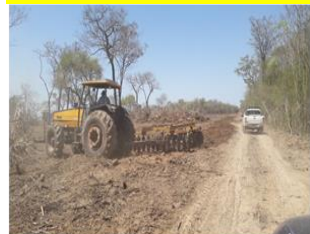
HABILITACION DE TIERRAS A TRAVES DE DESMONTE PARA LA CONSTRUCCION DEL CENTRO DE CONFINAMIENTO
