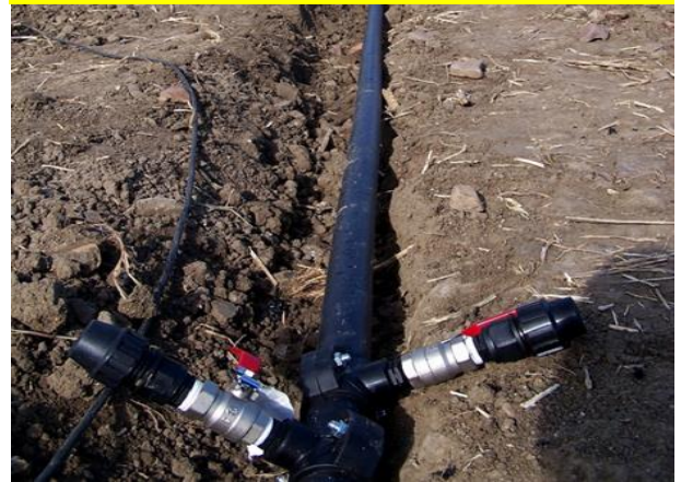
INSTALACION DE SISTEMA DE RIEGO CON USO OPTIMIZADO DE AGUA EN AREAS DE INTERVENCION DE ACCESOS ASAP
