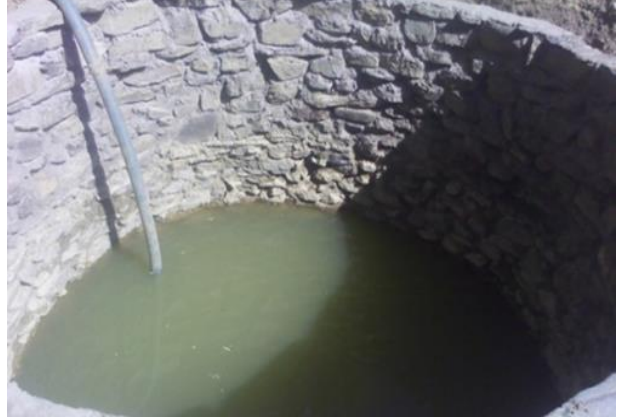
CONSTRUCCION DE POSOS PARA RIEGO POR SISTEMA DE BOMBEO
