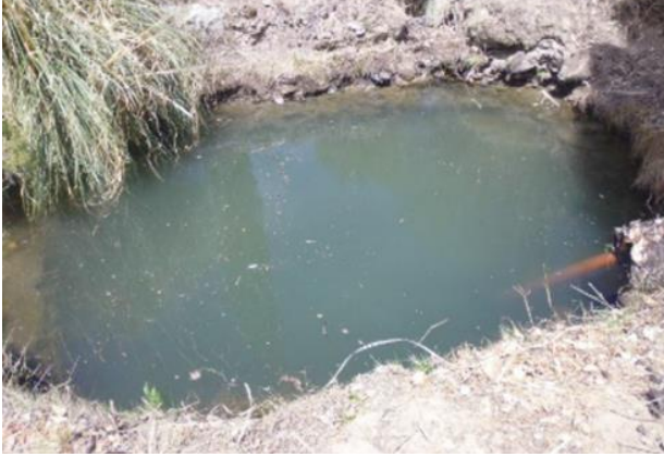
CONSTRUCCION DE POSOS DE AGUA PARA RIEGO Y CONSUMO ANIMAL
