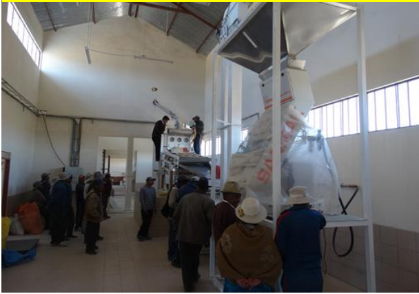
INSPECCIÓN TÉCNICA EN LA PLANTA BENEFICADORA DE SEVARUYO PARA PUESTA EN MARCHA
