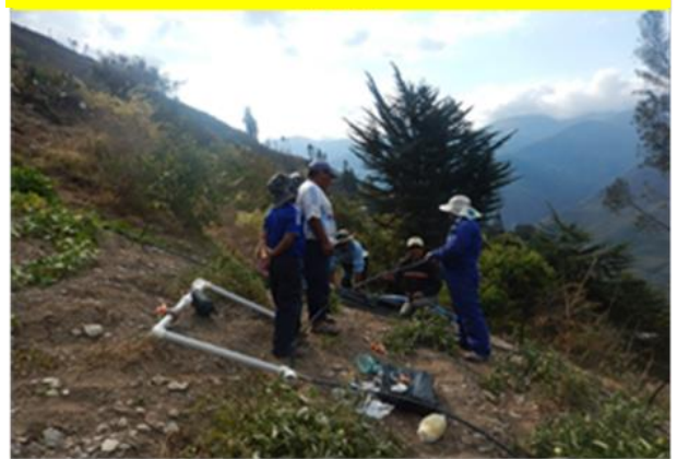
INSTALACION DE SISTEMA DE RIEGO POR GOTEO EN LA COMUNIDAD YAYHUATI - IRUPANA
