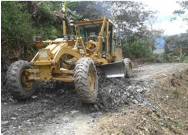
OBRAS DE MANTENIMIENTO DE CAMINOS EN LA COMUNIDAD DE SAN JOSE DE PERI MUNICIPIO DE CORIPATA
