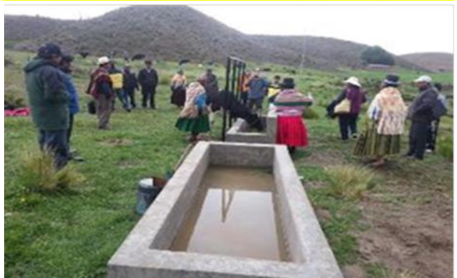
CONSTRUCCIÓN DEL SISTEMA DE AGUA POTABLE EN LA COMUNIDAD DE MURIA
