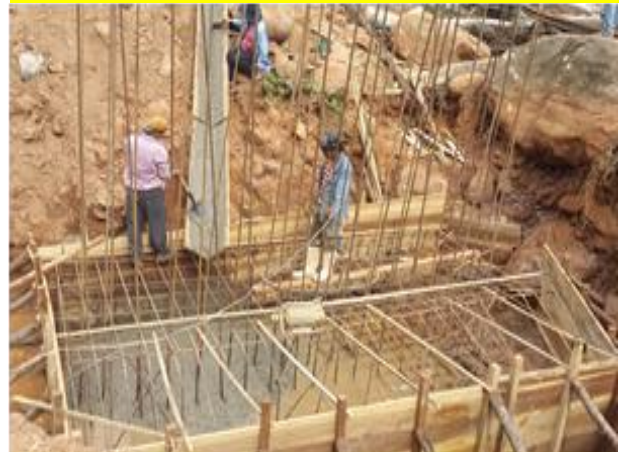
CONSTRUCCION DE PUENTE EN LA COMUNIDAD DE ALTO REMOLINO
